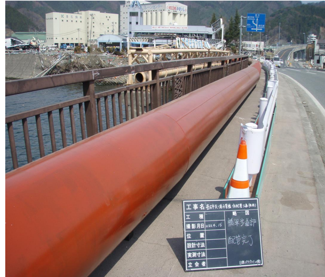
釜石市 国道上への幹線暫定設置
