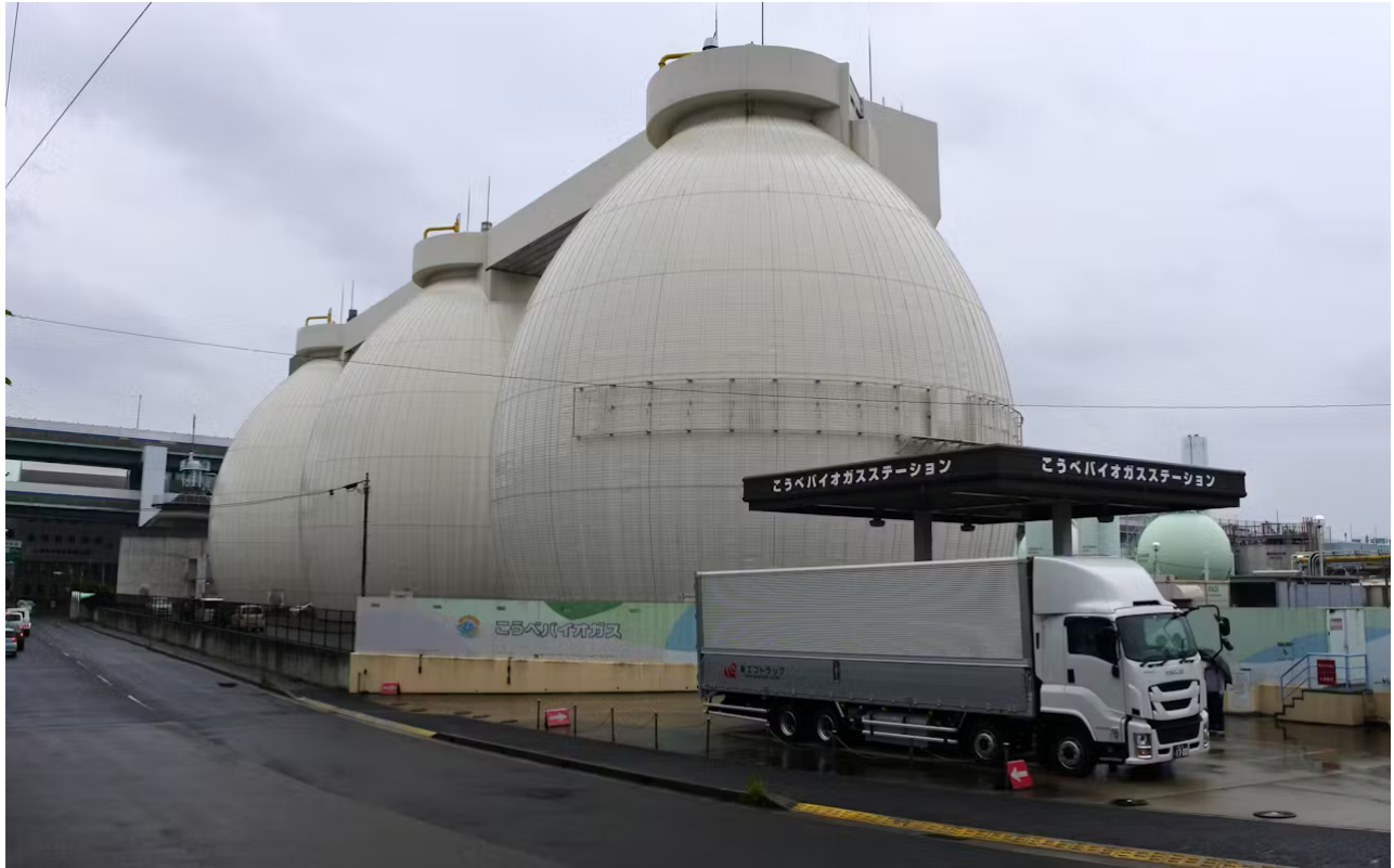
神戸市は下水処理場でバイオガスを精製し、輸送用に供給している（写真は東灘処理場）
